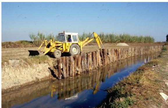
Obras de protección con material natural para evitar la erosión en el canal perimetral de la laguna
